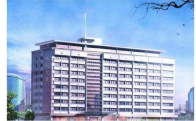
杭州风起大厦
