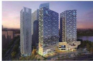
安徽合肥新闻大厦
