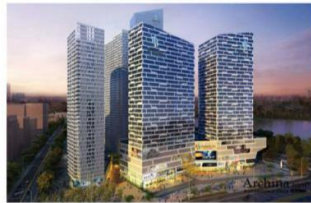
安徽合肥新闻大厦
