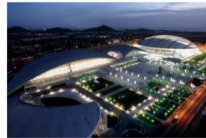
南通国际码头广场
