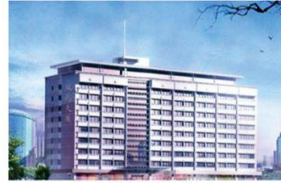
杭州风起大厦
