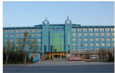
济南大陆机电办公楼
